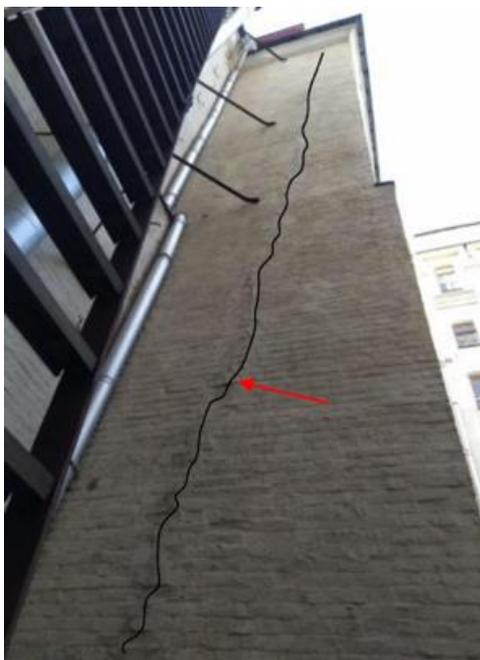
Рисунок 1. Трещины на фасаде Государственного Исторического музея с раскрытием до 1 см
