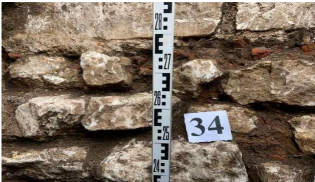
Рисунок 1. Рядная кладка блоков известняка на глинистом растворе
